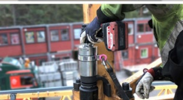
Drehschrauber ADS 600 Eckstielverbindung M45, M A = 5.850 Nm
